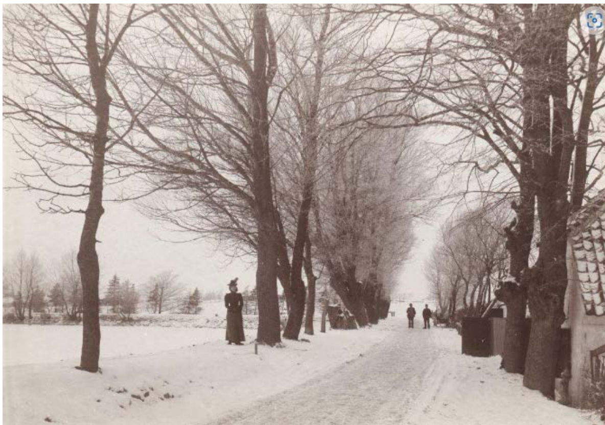
Ålekistevej kan føres tilbage til 1700-tallet. Her som området så ud omkring år 1895 set mod nord fra Ålekistehuset fra Ålekistevejs sydlige ende.
